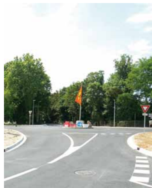
Réalisation du carrefour giratoire du Val Hureau. Cette année encore la commune consacrera une grande partie de son budget d'investissement à la voirie
